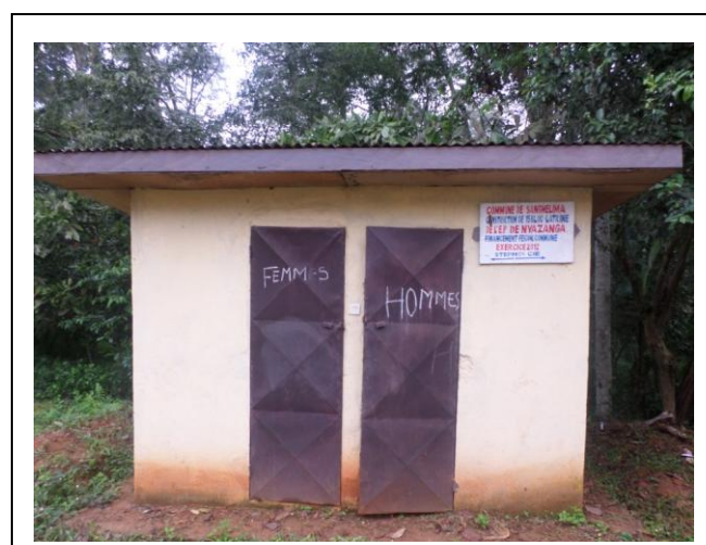
Photo 4 : Latrines de l'école publique de Nyazanga
